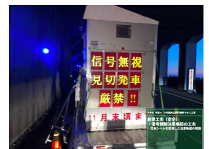
注意喚起表示増設 (夜間視認性の確保)
