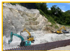
[ マシンガイダンスによるICT施工 ]
