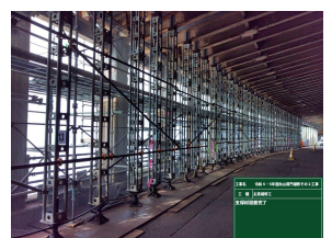
支保工の水平連結補強
