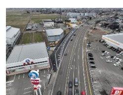
三車線化完了
