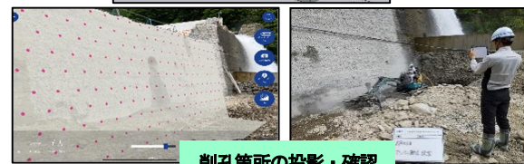
削孔箇所の投影・確認
