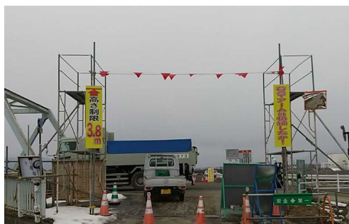
出入口高さ制限ゲート
