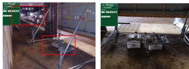
【写真-1】騒音振動設置状況
