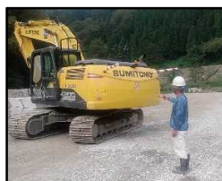
重機静止状況
