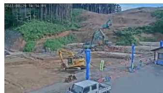
府屋地区地盤改良箇所
