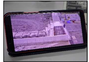
現場監視カメラの映像
