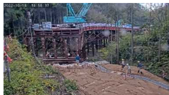
基石地区道路及び仮橋施工箇所
