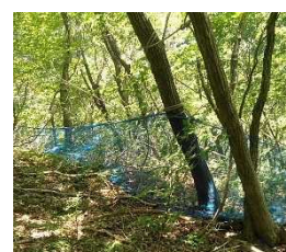
写真1 落石防止ネット設置
