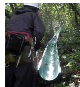
写真2 簡易シュートの設置
