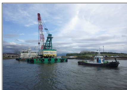
台船曳航状況写真
