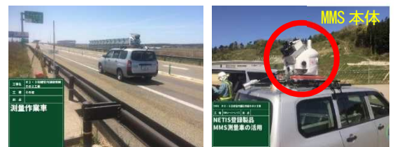
【写真-1】MMS 測量（モバイルマッピングシステム）
