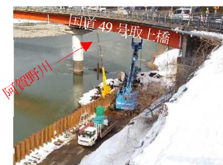
工事現場施工状況
