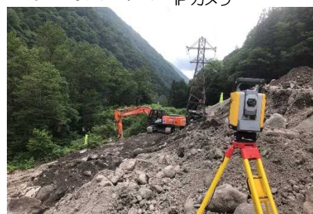
ICT 建機による施工（TS方式）
