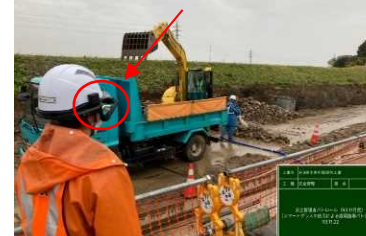
スマートグラスによる遠隔臨場安全パトロール
