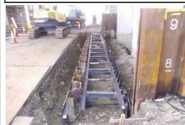
電力管保護 仮設土留工
