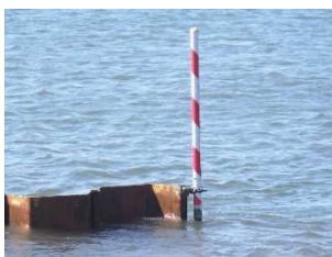
矢板位置標示ポールの設置
