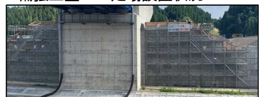
補強土壁工 足場設置状況
