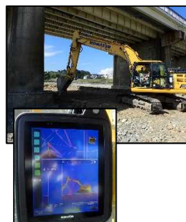
防護ラインデータ搭載 ICT 建機
