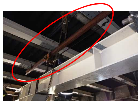
写真2 トロリーによる架設
