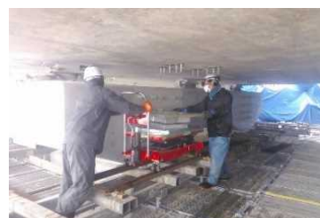
桁下 耐震部材台車運搬
