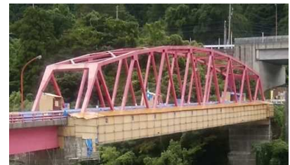
密閉設備の足場
