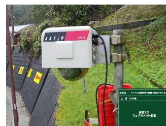
ネットワークカメラ設置状況
