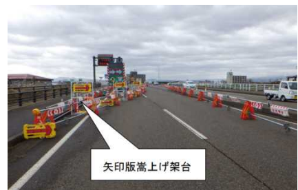
下り橋梁に交通を切替
