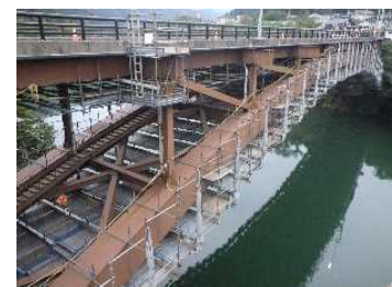
強風対策：朝顔部足場シートの取外し
