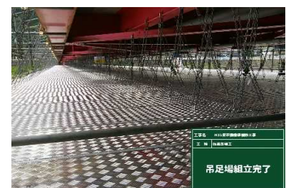
パネル式吊り棚足場状況
