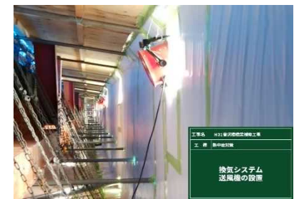
足場内の換気及び送風状況
