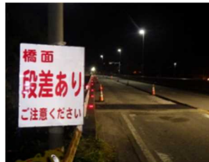
段差あり看板設置
