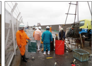
支店 安全衛生パトロール(9月20日) (山下安全環境部長)
