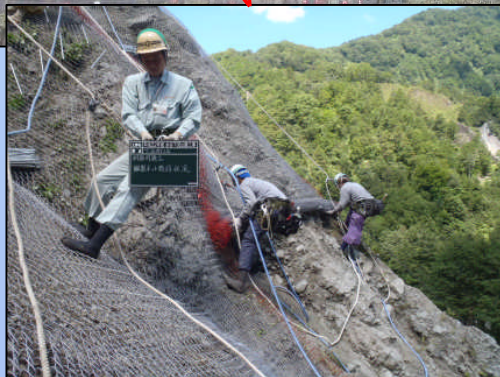
鋼製ネット敷設状況
