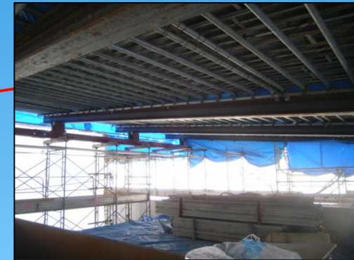
雪寒仮囲い内部の様子
