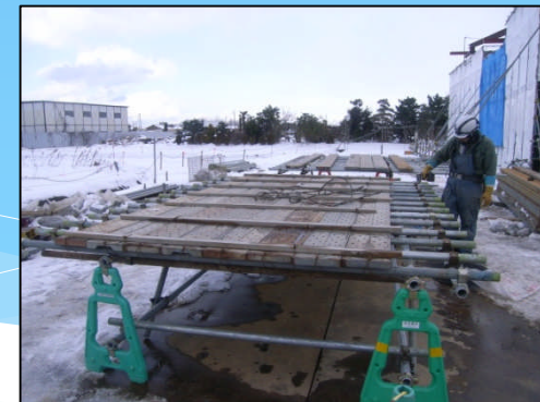
屋根部材のパーツ化
