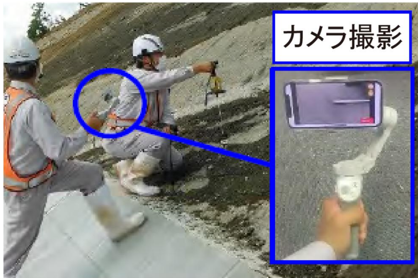
現場での受注者による計測状況
