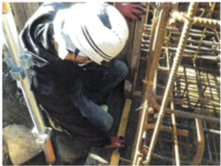
膝の上に釘打機を置いて、両手で作業を実施
