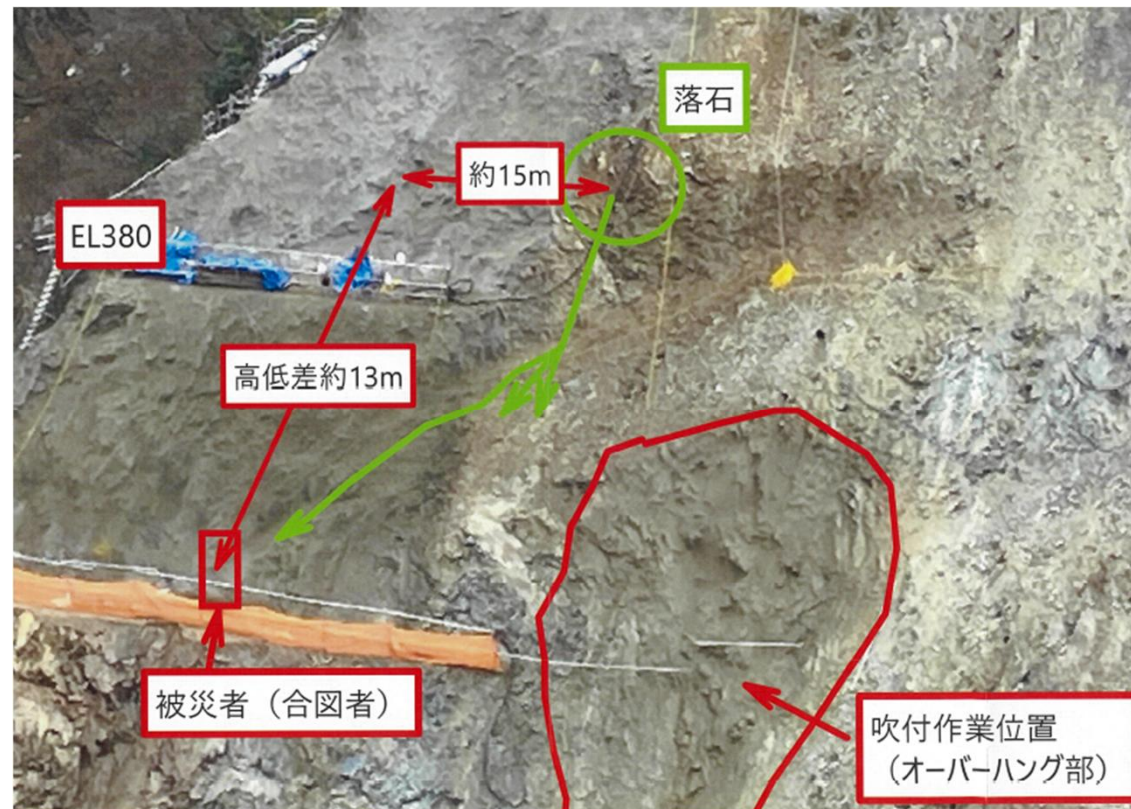
事故発生現場写真
