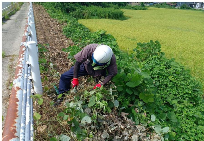
繁茂しているつる草の除去作業状況 （難しい体勢での作業）
