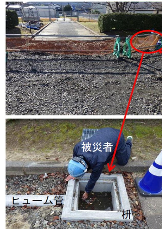
事故発生時の再現写真
