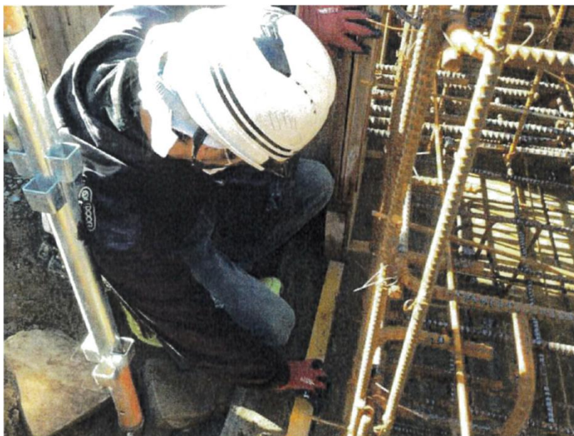
膝の上に釘打機を置いて、両手で作業を実施
