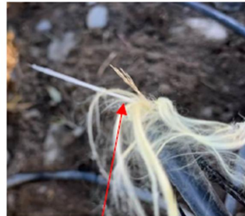
光ケーブル切断部分
