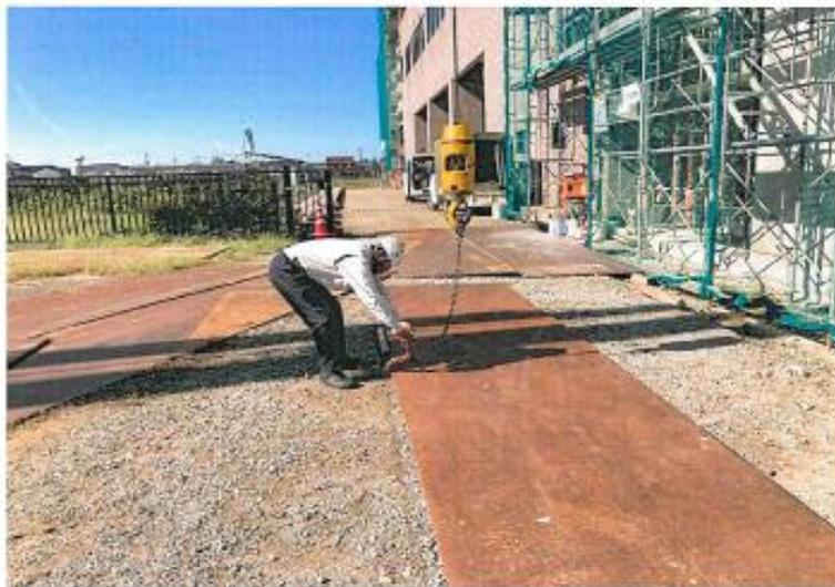
敷いていた鉄板の吊穴にフックをかけるため、まず鉄板のふちにフックを仮掛けし10cm程度鉄板を浮かせ枕木を差し込みました。このときフックが確実にかかるよう、吊りチェーンを手で引張り位置を調整した。
