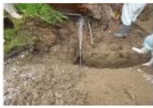
水道管破損状況
