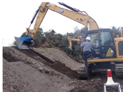
【施工実技】3DMC・MGバックホウによる床掘・法面整形(JCMA)
