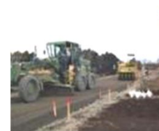
丁張りに合わせて 施工
