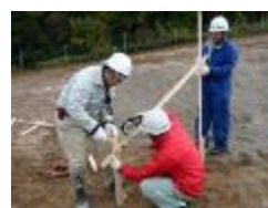
設計図に合わせ 丁張り設置
