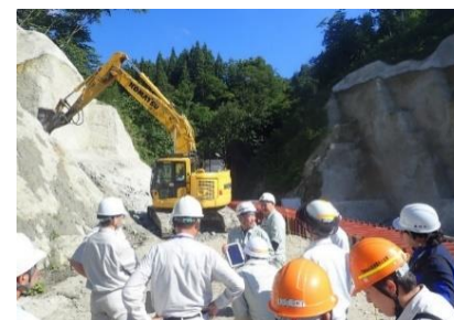
【実技】ICT施工(杭ナビショベル)(飯豊)
