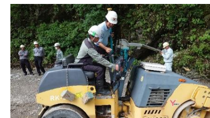
【実技】ICT建機の操作体験(立山)
