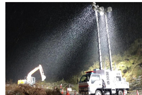
昼夜を徹した道路啓開作業 (石川県)
