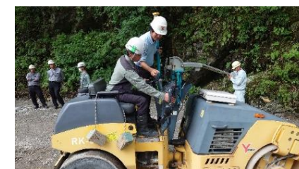
【実技】ICT建機の操作体験(立山)
