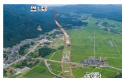
【日本海沿岸東北自動車道】
