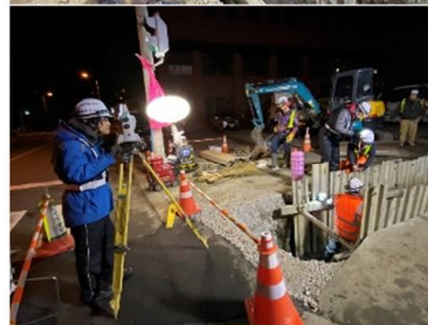
(TS等光波方式の計測成果)
