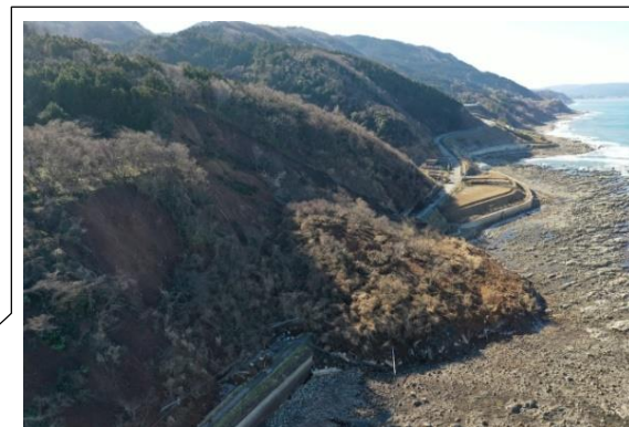
国道249号の地すべり及び 大規模隆起した海岸線(石川県輪島市)
