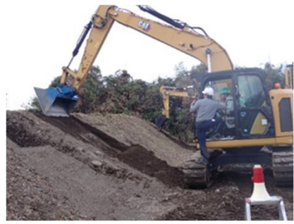
【施工実技】3DMC・MGバックホウによる床堀・法面整形(JCMA)
