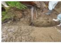
水道管破損状況
