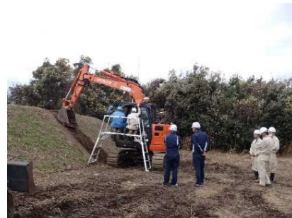
【施工実技】3D MG・MCバックホウによる床堀・法面整形(JCMA)
