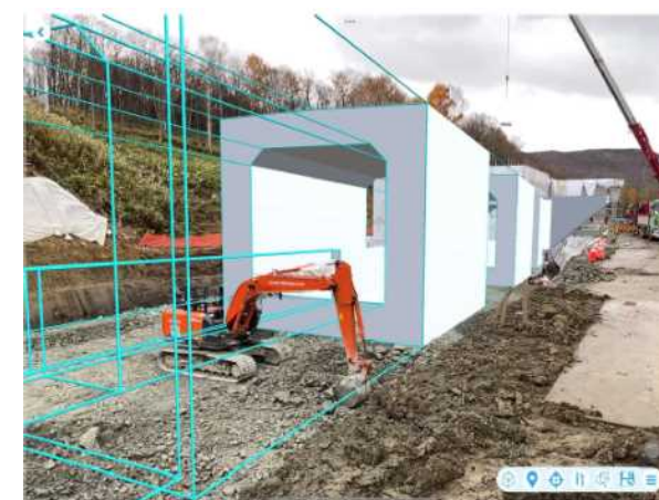
掘削作業時にARと比較した同時出来形管理
