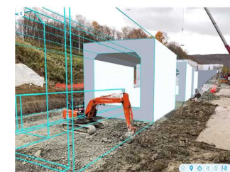
掘削作業時にARと比較
