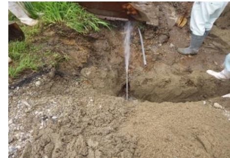
水道管破損状況
