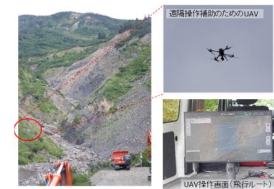
【実技】UAVによる施工補助(金沢)
