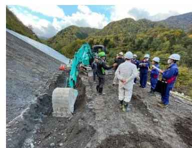
【実技】ICT建機の実演(神通川)
