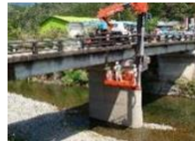
インフラの維持管理(点検作業)
