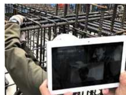
Webカメラを利用した遠隔検査
