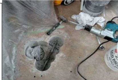
穿孔機で既存電線管損傷状況
