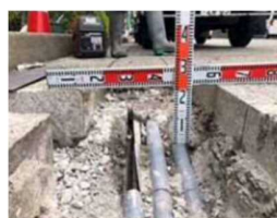
切断した埋設管
