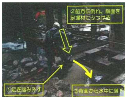
事故状況写真
