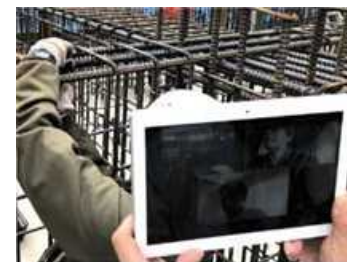
Webカメラを利用した遠隔検査
