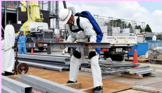
災害現場における重量物運搬の例
