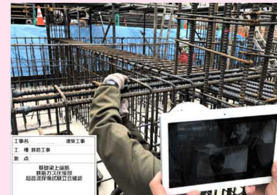
Webカメラを利用した遠隔検査
