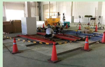
工事エリアの区画を設定して作業
