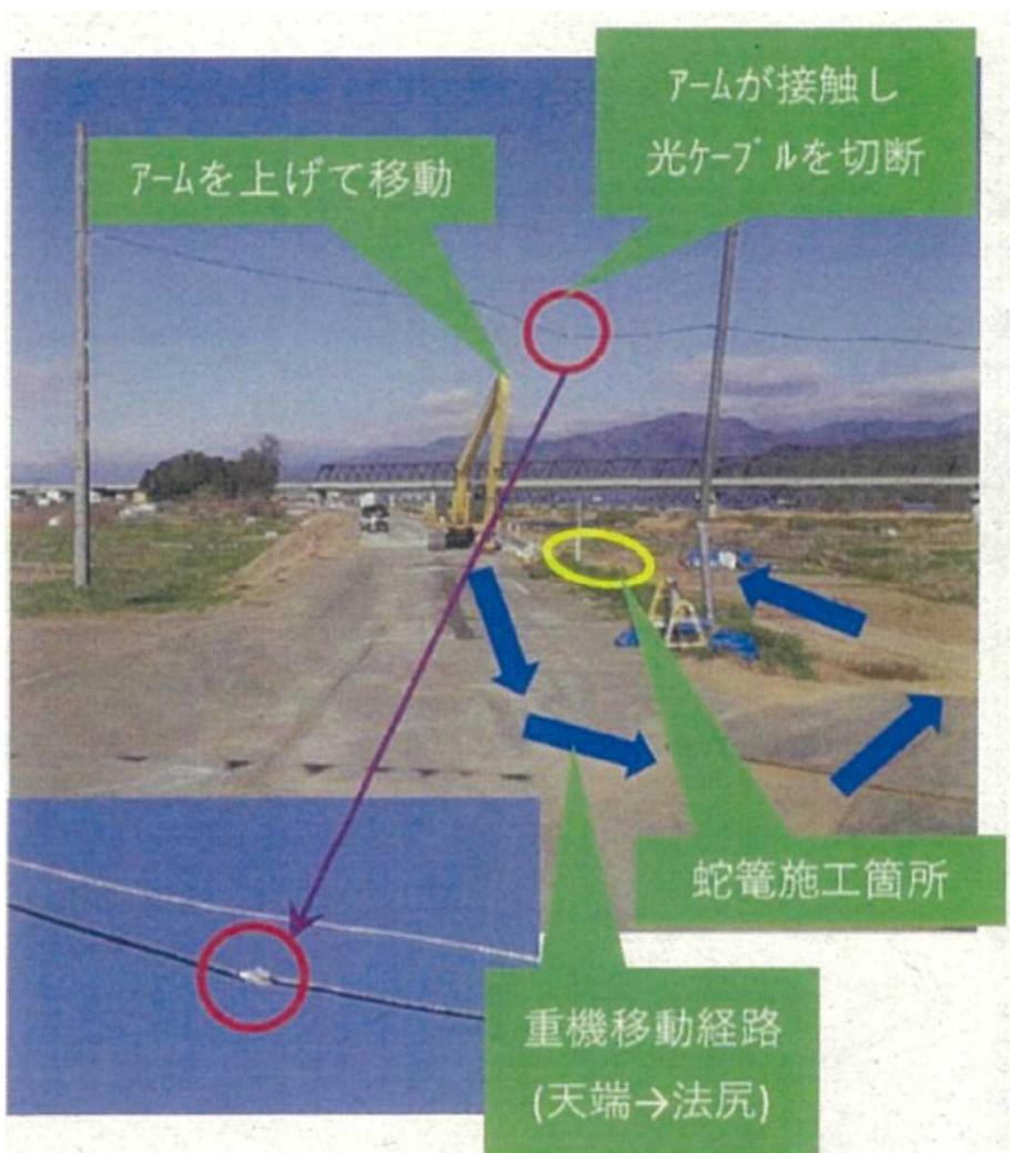
事故発生状況
