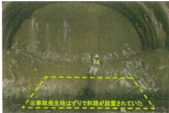
事故状況(全体)
