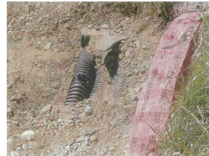
損傷状況写真
