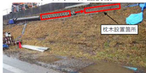
事故発生状況
