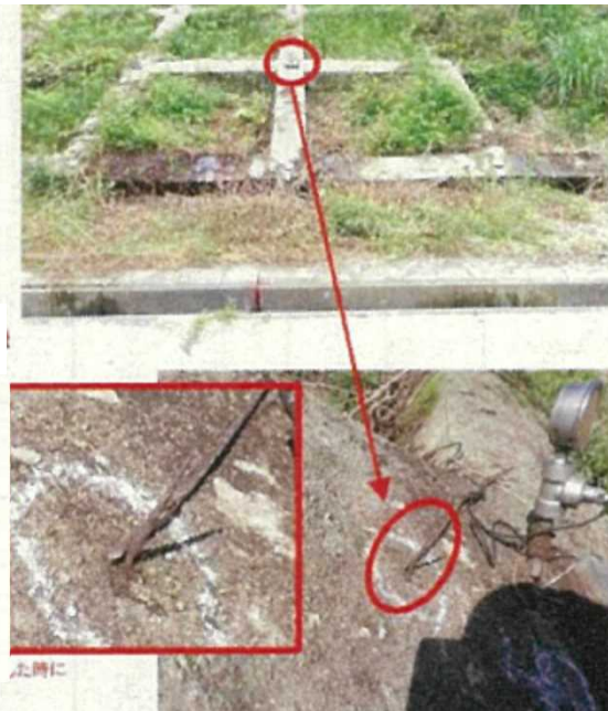
法枠から突出した釘(長さ50mm)
