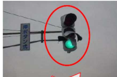
接触による破損
