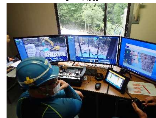
【実演】ICT建機操縦(神通砂防) [R2年度]
