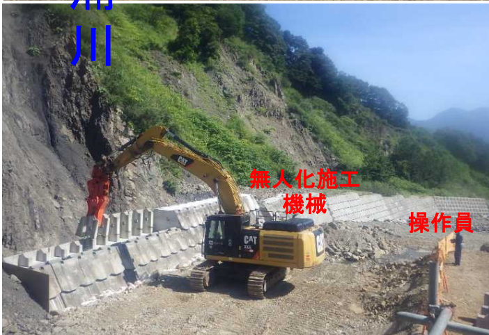
無人化施工による護岸工の状況 (遠隔目視操作)
