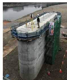
従来施工 (高所での測量)
