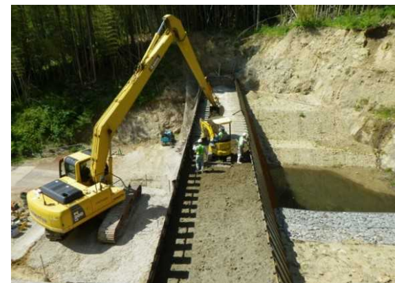
敷均し・締固め
