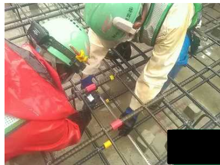
鉄筋検査(ウェアラブルカメラ)
