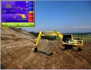
ICT建設機械の補助機能を活用し、オペレータが建設機械を運転
