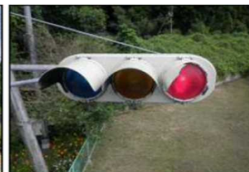
写真2 破損した信号機
