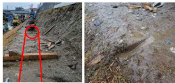
ケーシングパイプ固定状況
