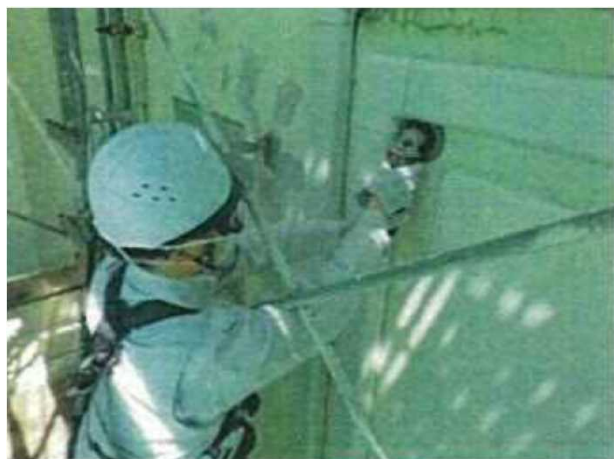
グラインダーの集塵カバーを外して作業。
