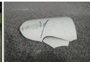
写真3 落下した信号機破損部
