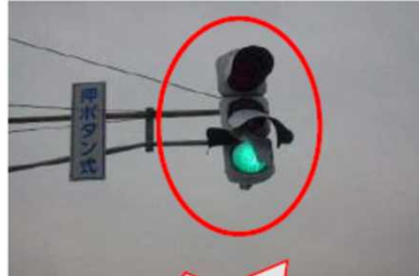
接触による破損
