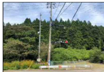
写真1 事故発生箇所
