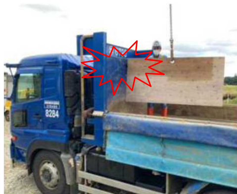
事故発生時の状況
