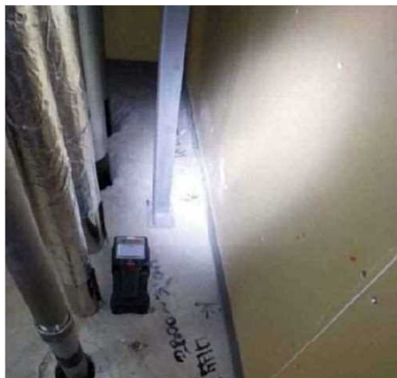
コア抜きウオールスキャナーでの確認状況
