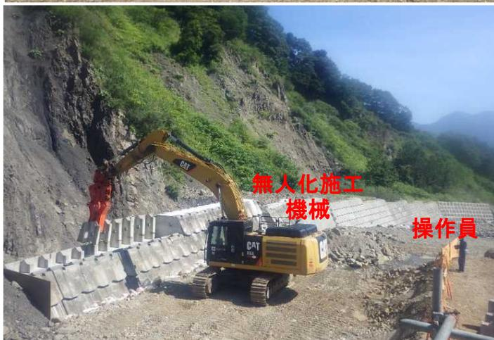
無人化施工による護岸工の状況
