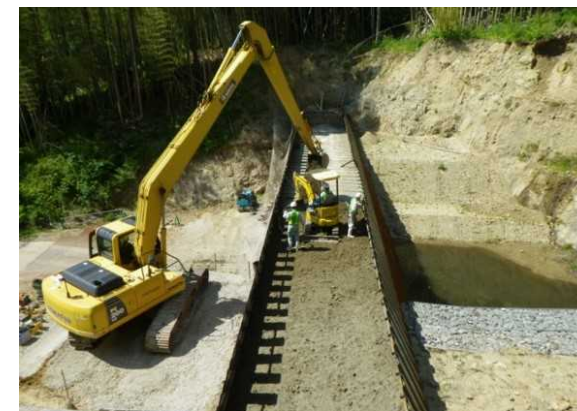
敷均し・締固め
