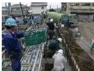
標準的な工法（コンクリート打設）
