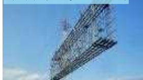
鉄筋先組工法
