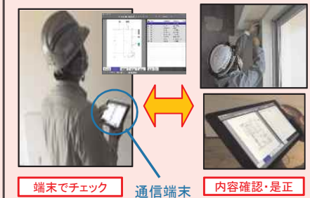
通信端末で内装仕上げの確認・是正
