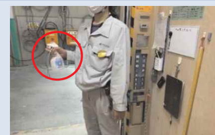
EVの操作盤等の消毒を徹底
