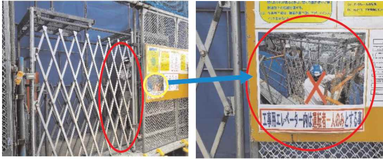
工事用エレベーターの定員を限定、ポスターを掲示
