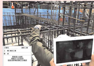
Webカメラを利用した遠隔検査
