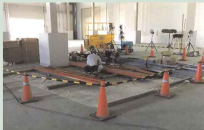
工事エリアの区画を設定して作業
