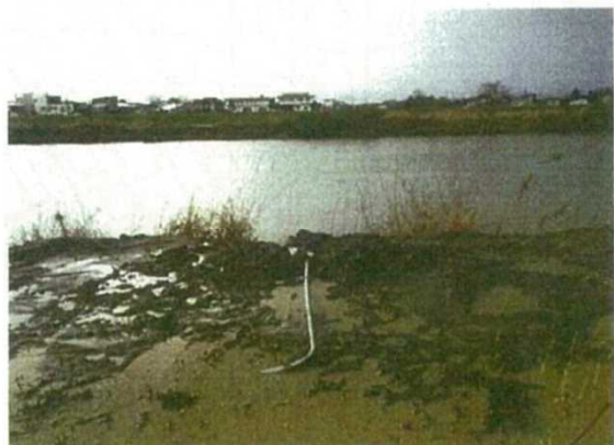
破損状況(川岸を望む)
