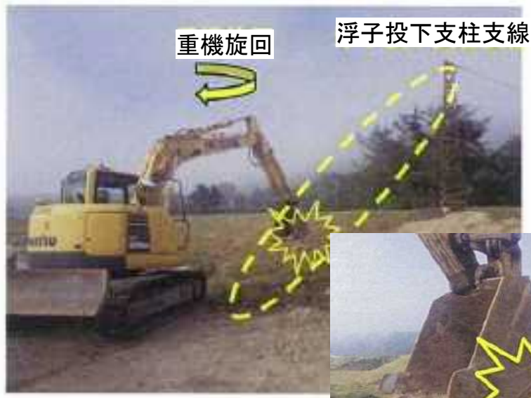
支線わきで重機旋回作業
