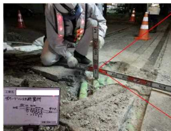
開削後(埋設深 55mm~110mm)
