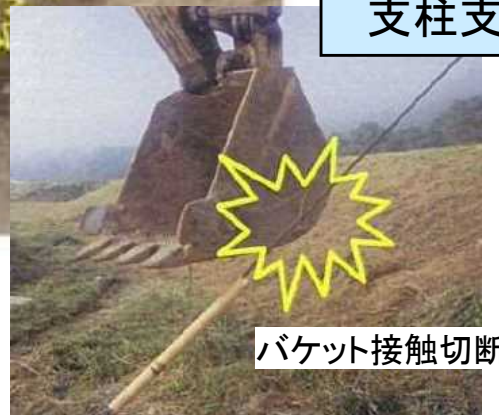
支線わきで重機旋回作業
