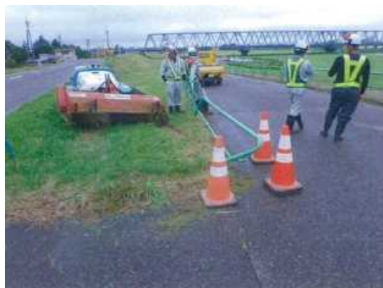
防護柵の破損
