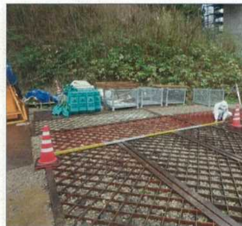
路面状況 (ロードマットを敷設)
