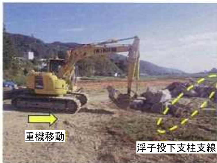
コンクリート殻小運搬・集積作業状況
