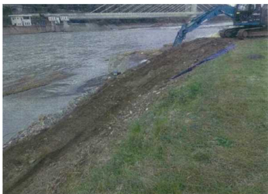
坂路機械設置状況
