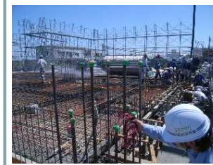
標準的な工法 (鉄筋結束)
