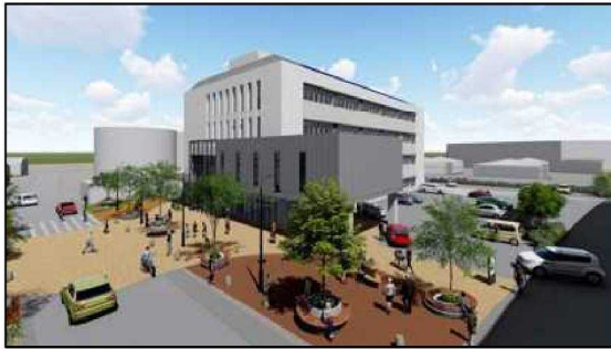
栃木地方合同庁舎(H30.9着工～)
