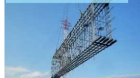
鉄筋先組工法
