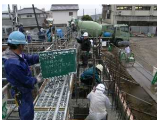
標準的な工法 (コンクリート打設)
