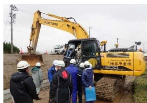
ICT施工(MGバックホウ)法面成形搭乗体験
