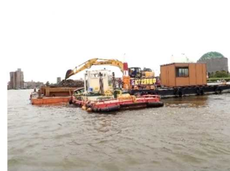
浚渫現場の様子
