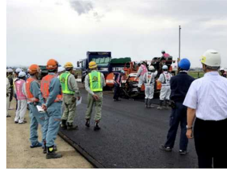
施工中のTSアスファルトフィニッシャ
