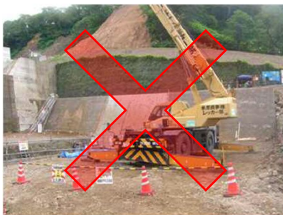
排ガス・低騒音機械確認写真
