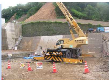
排ガス・低騒音機械確認写真
