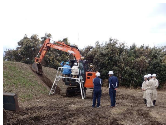
【施工実技】3D MG・MCバックホウによる床堀・法面整形(JCMA)
