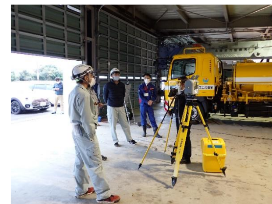
【測量実技】TSによる断面管理(JSIMA)
