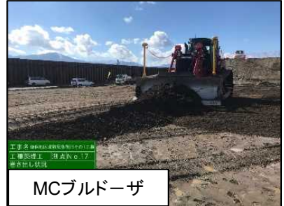
ICT建設機械施工状況
