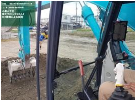
MGバックホウによる掘上げ
