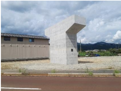
RC橋脚工 完了
