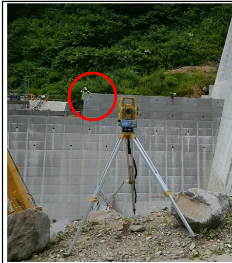
丁張レスによる残存型枠設置
