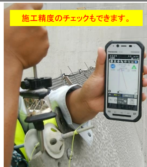
丁張レスによる残存型枠設置
