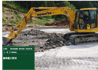
MG(マシンガイダンス) 搭載バックホウ
