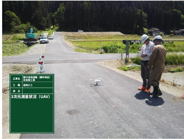
RTK搭載のUAVによる3次元起工測量
