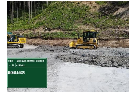
MG(マシンガイダンス) 搭載バックホウ
