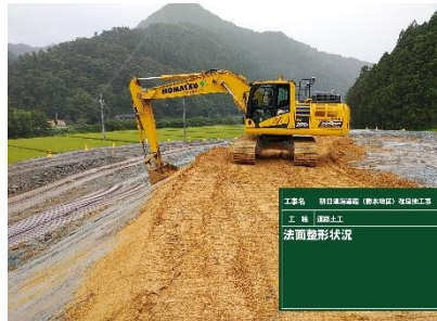
MC(マシンコントロール) 搭載バックホウ
