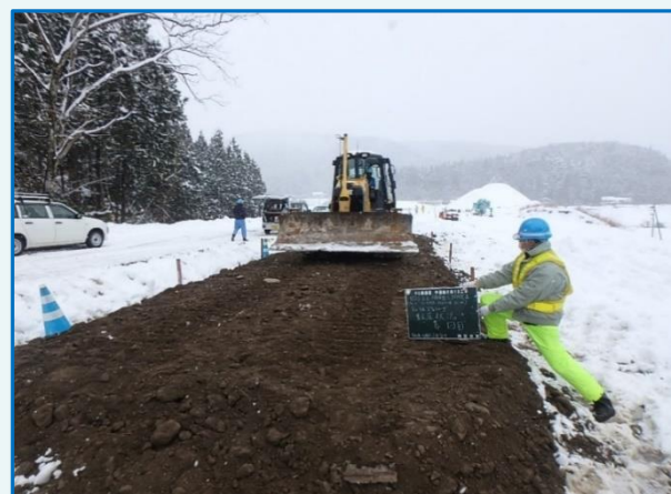
冬期MCブルドーザによる試験盛土の転圧確認
