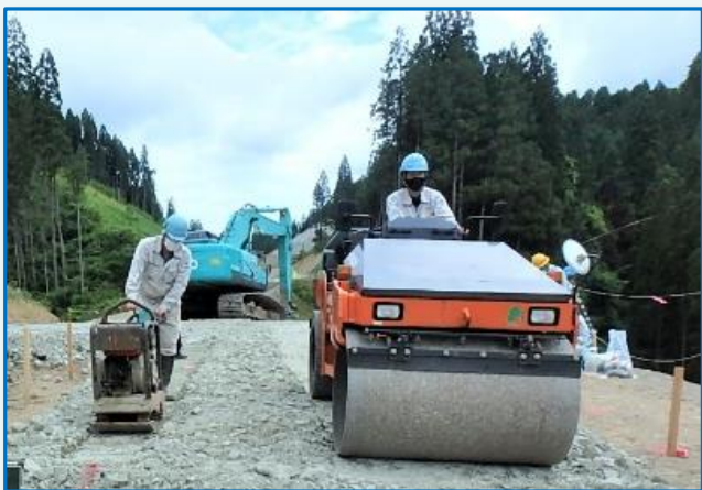
狭隘な施工箇所を見据えた試験盛土の転圧確認
