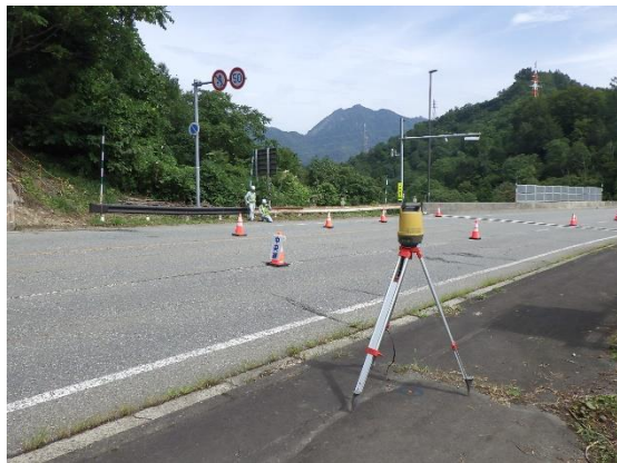
LN-150(自動追尾TS)と快測ナビ (ICT施工現場端末アプリ)を使った測量状況
