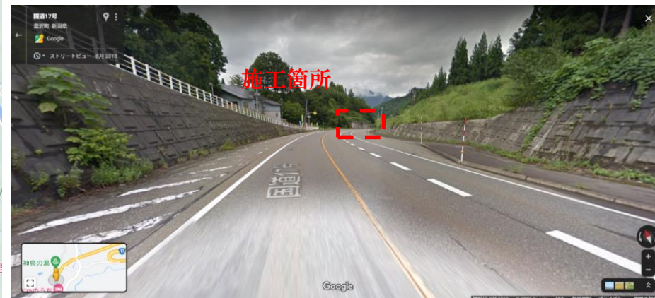
施工箇所より150メートル手前 下り6%勾配の右カーブ
